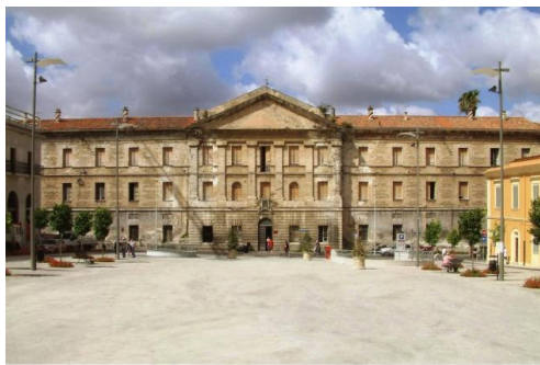
Ex Ospedale Civile di Sassari Sa. Annunziata Prospetto principale, piazza Fiume
